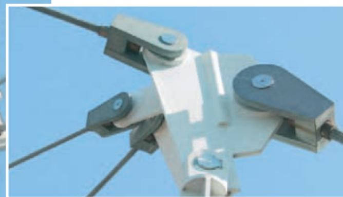
Filigran und trotzdem extrem belastet: Trageileanbindung der Dachkonstruktion
