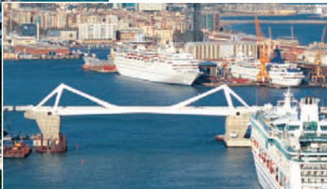
Barcelona. Die derzeit größte Doppelklappbrücke der Welt schwenkt auf wartungsfreien Großgelenklagern mit 670 mm Bohrungsdurchmesser
