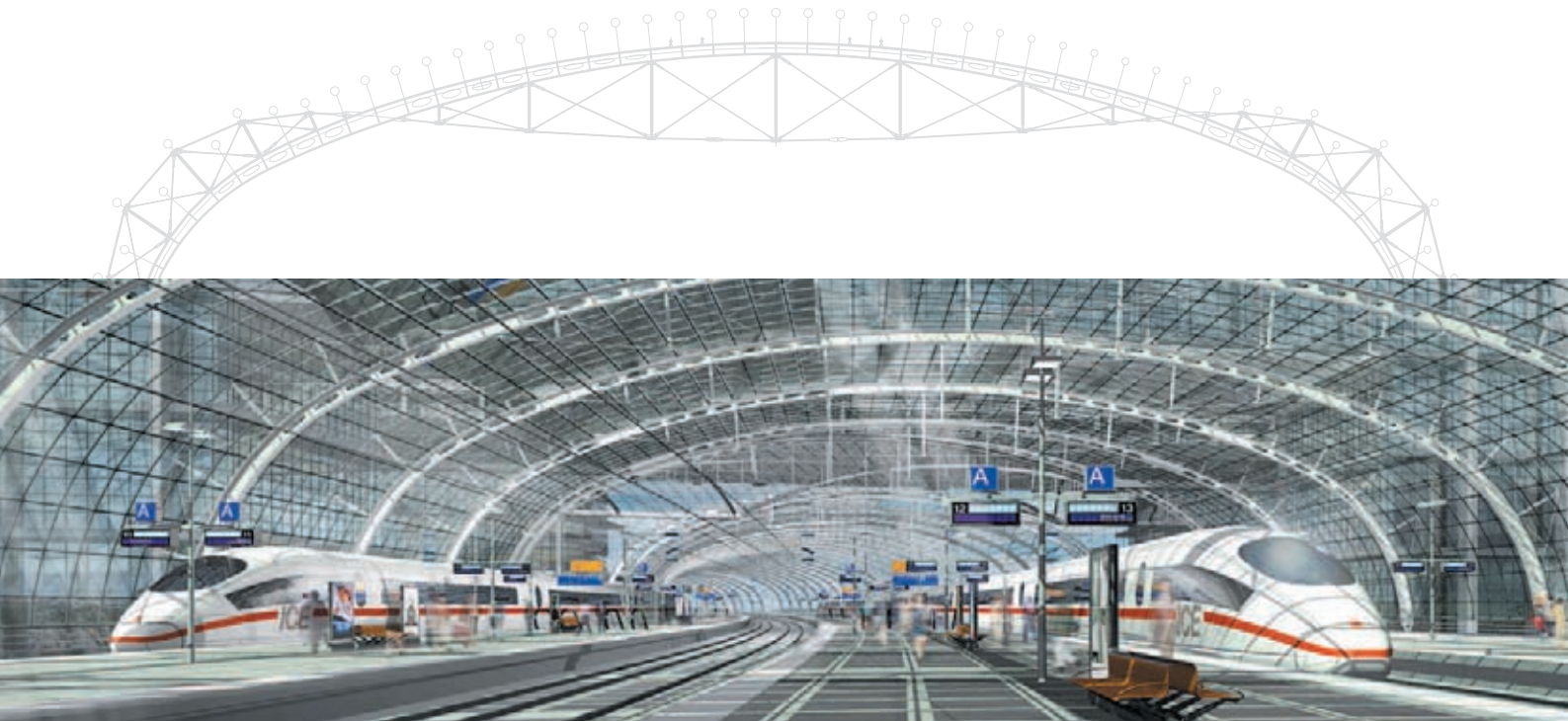
Lehrter Bahnhof Berlin: Die Dachkonstruktion des größten europäischen Bahnhofs überspannt ca. 300 Meter Bahnsteig und enthält zahlreiche ELGES-Gelenklager/Bolzensysteme (Bild Computersimulation (C) Archimaton, Berlin)
