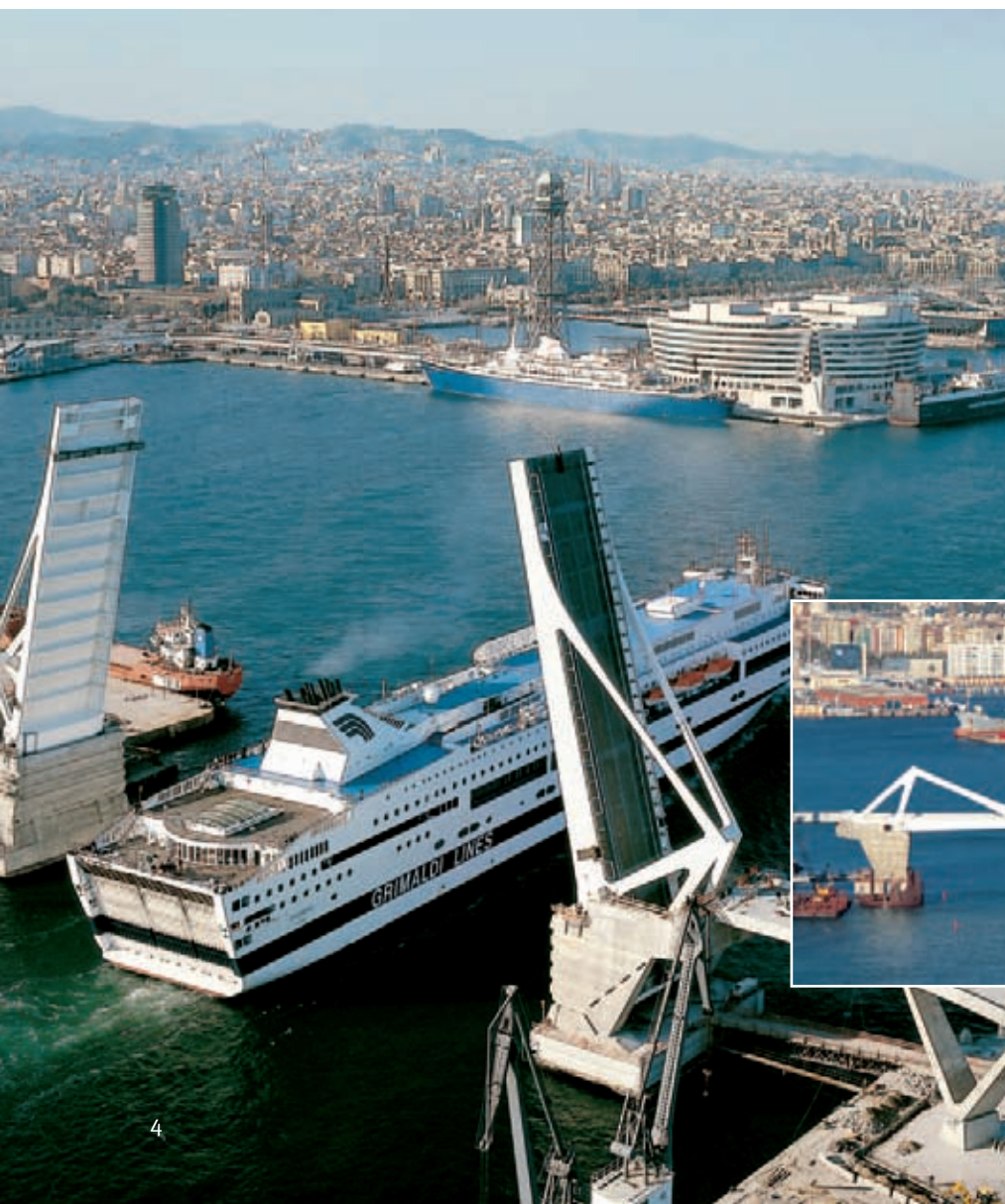
Barcelona. Die derzeit größte Doppelklappbrücke der Welt schwenkt auf wartungsfreien Großgelenklagern mit 670 mm Bohrungsdurchmesser
