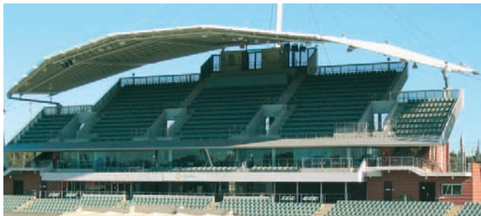
State Hockey Centre Sydney: Alle Seilanlenkpunkte am Dachrand und an den Masten sind in ELGOGLIDE®-beschichteten Gelenklagern gelagert
