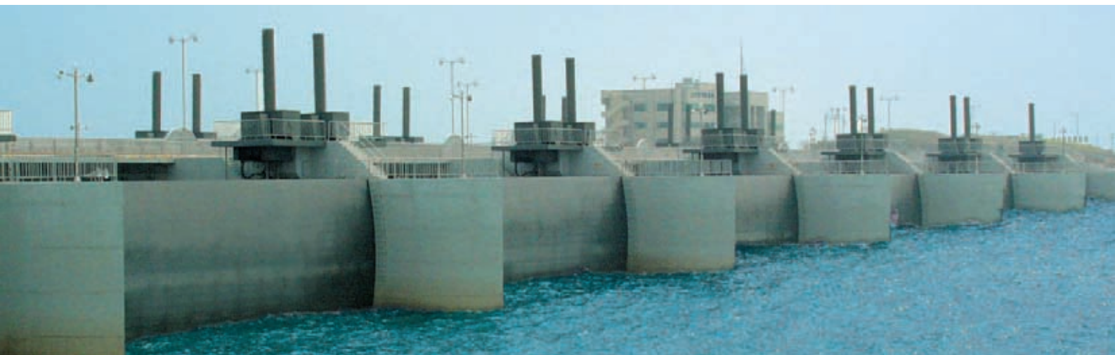
Landgewinnung in Korea – Saemangum: Der 2001 fertiggestellte Staudamm ist ein Vorzeigeprojekt und gleichzeitig einer der interessantesten Einsatzfälle von ELGES-Produkten
