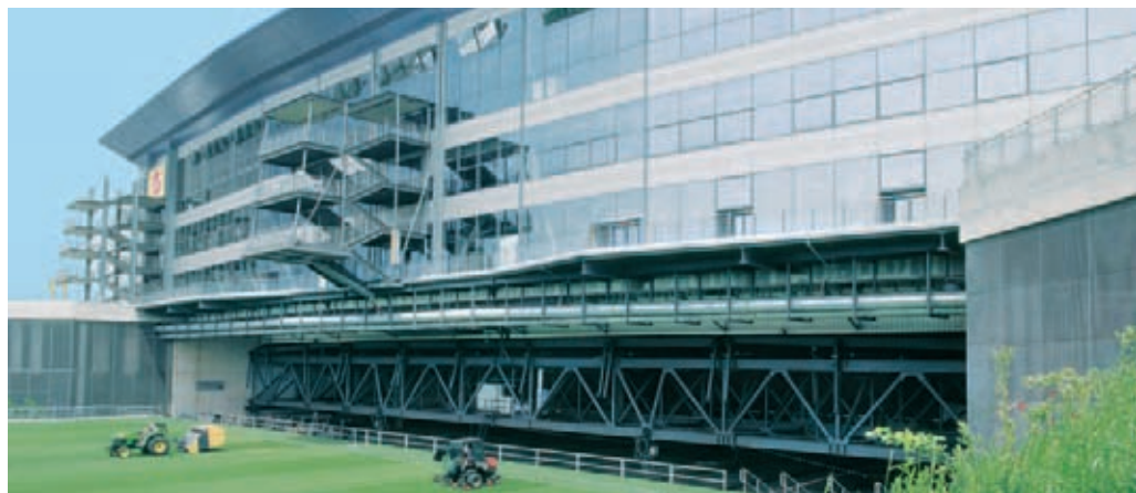
Arena „AufSchalke“, Gelsenkirchen: Das Spielfeld, das hier noch malerisch vor dem Stadion liegt, braucht sechs Stunden für seinen 300 Meter langen Weg ins Innere des Stadions
