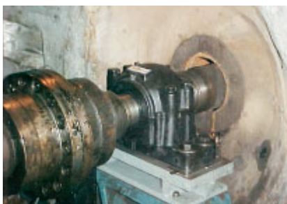
Lagerungen in Gebläsen und Ventilatoren
